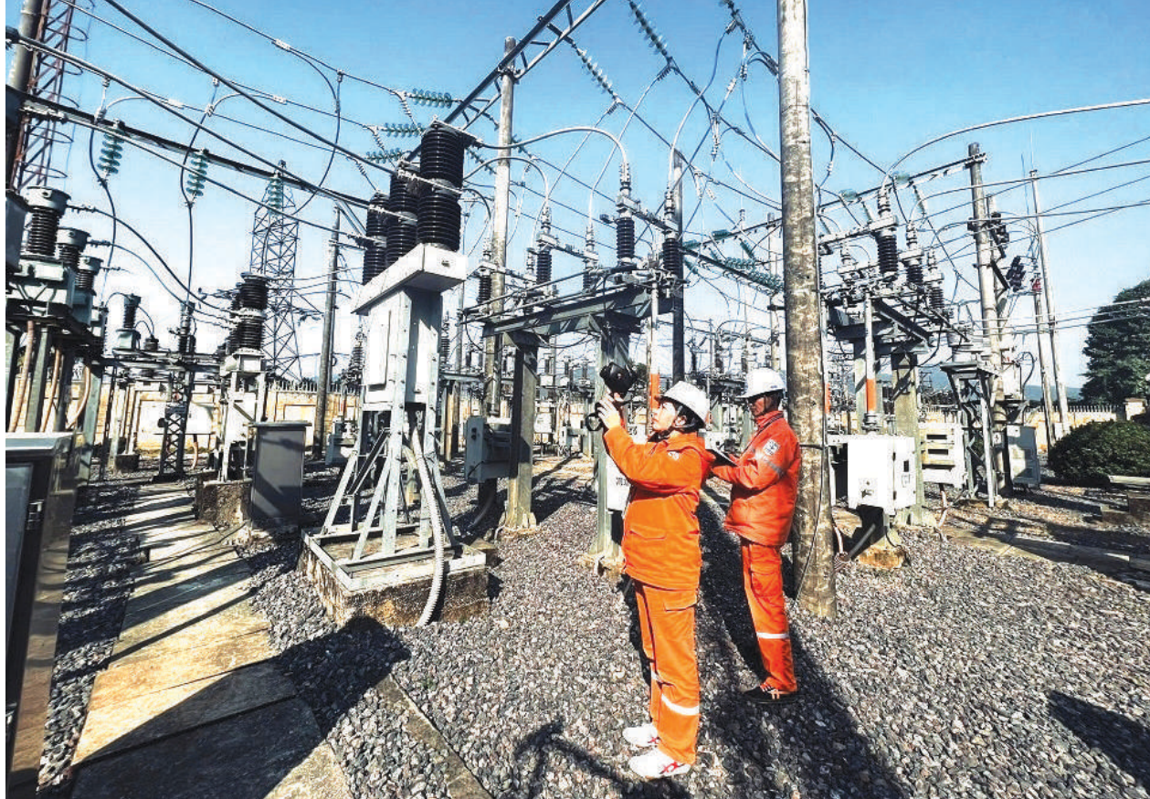
CTĐL Cao Bằng là một trong những đơn vị tiên phong trong việc xây dựng hệ thống lưới điện thông minh
