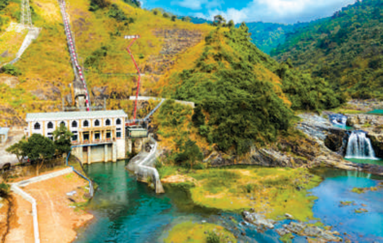
Nhà máy Thủy điện Quảng Trị sẵn sàng phương án vận hành mùa khô năm 2026
