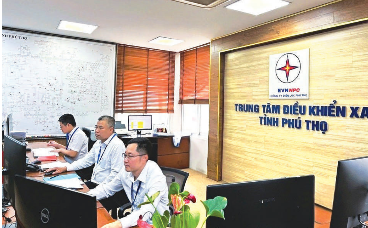
100% trạm biến áp 110kV được duy trì ở chế độ không người trực
