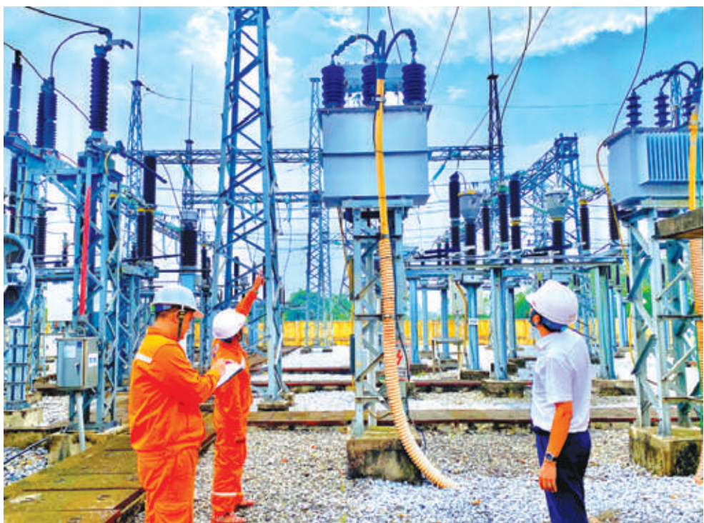
Cán bộ công nhân viên CTĐL Phú Thọ kiểm tra, bảo trì lưới điện
