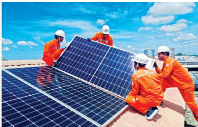
Ngành Điện lắp đặt điện mặt trời trên mái nhà dân
