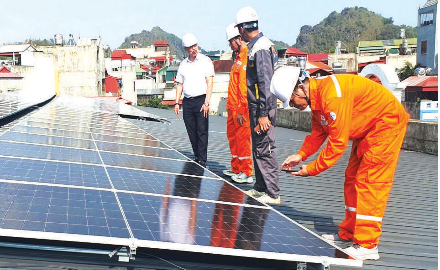
Công ty Điện lực Sơn La phối hợp kiểm tra việc lắp đặt hệ thống điện mặt trời mái nhà tự sản, tự tiêu
