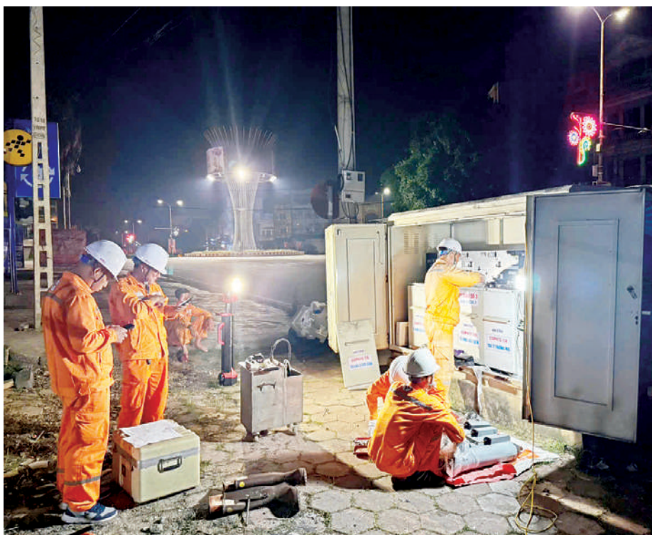
Nhân viên CTĐL Thái Nguyên nỗ lực sửa chữa lưới điện giữa đêm tối nhằm đảm bảo cấp điện phục vụ Nhân dân
