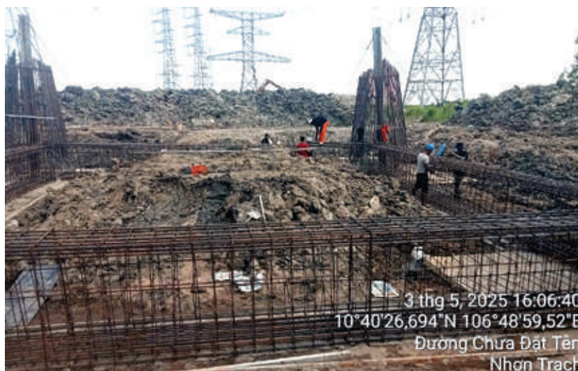
Thi công buộc thép móng vị trí 17 thuộc Dự án đường dây 220kV Nhơn Trạch 3 - rê Mỹ Xuân - Cát Lái
