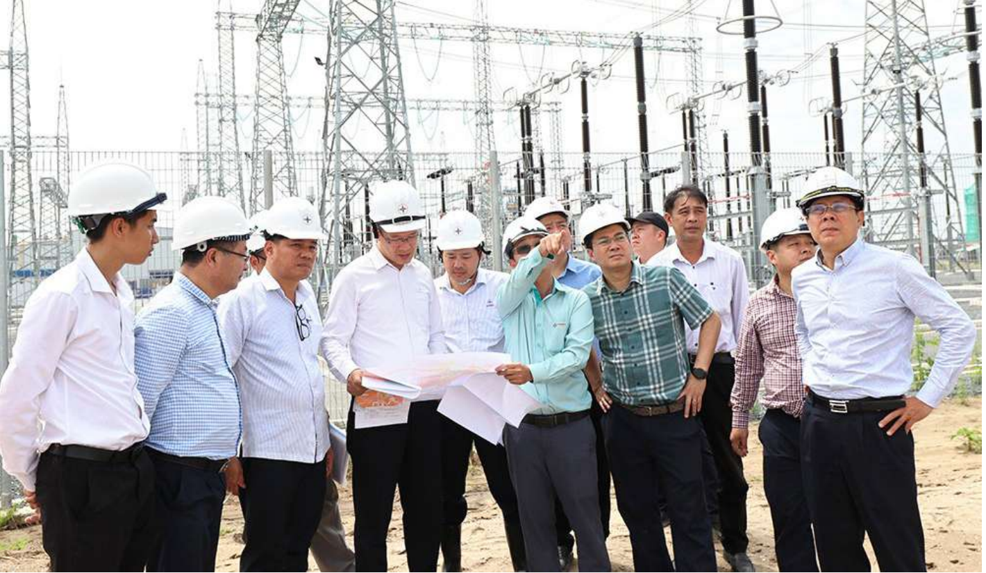
Phó Tổng giám đốc EVNNPT Nguyễn Ngọc Tân cùng đoàn công tác kiểm tra thi công vị trí đấu nối vào Sân phân phối Nhà máy điện Nhơn Trạch 3
