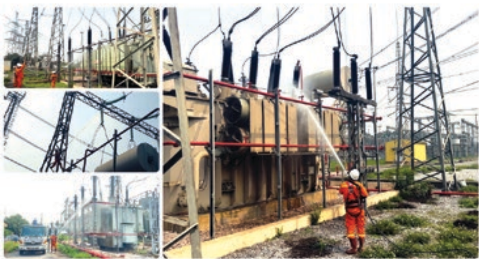
Vệ sinh hotline tại trạm biến áp 220kV Hà Đông trước cao điểm mùa nắng nóng
