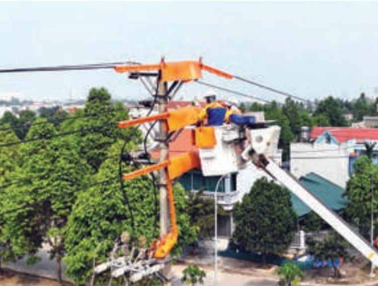
Ứng dụng công nghệ sửa chữa điện Hotline giúp giảm thiểu tối đa thời gian mất điện của khách hàng
