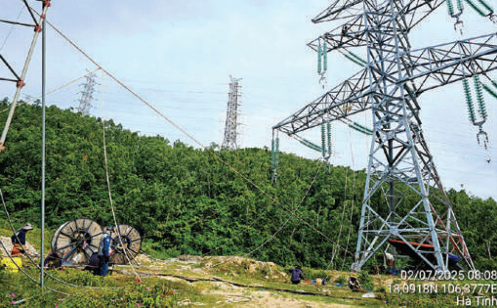
Việc kéo dây tại các khoảng néo là một trong những khâu phức tạp nhất, đòi hỏi sự đảm bảo an toàn tuyệt đối
