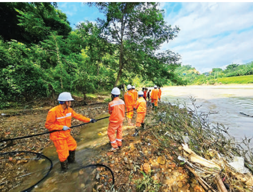
PC Cao Bằng tiến hành nâng cấp hệ thống đường dây tại các vị trí xung yếu
