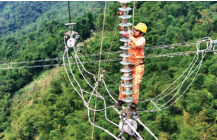
PTC1 thay sứ tại vị trí cột 354 thuộc ĐZ 500kV Sơn La - Hòa Bình
