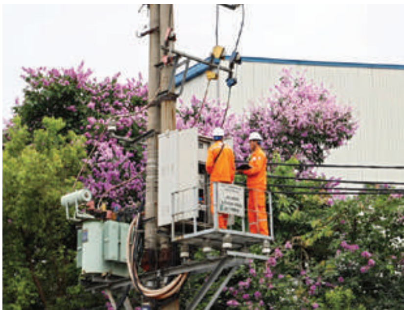
Công nhân PC Vĩnh Phúc chủ động kiểm tra và xử lý kịp thời các tồn tại, khiếm khuyết trên lưới điện
