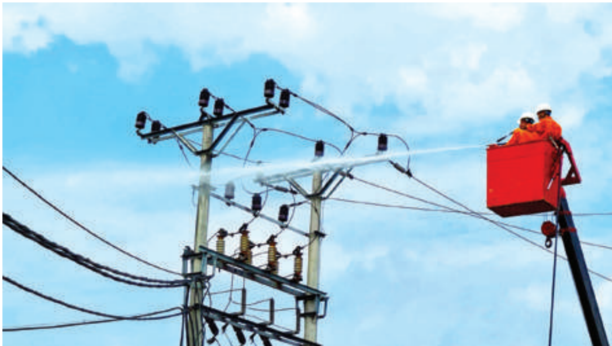
PC Bắc Ninh vệ sinh sứ cách điện bằng nước áp lực cao
