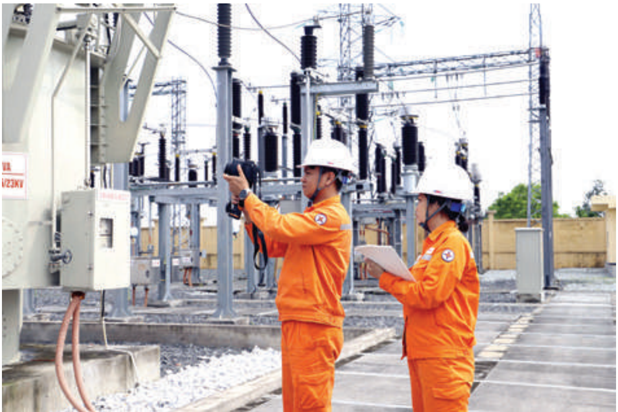
PC Vĩnh Phúc đo thiết bị bằng camera nhiệt nhằm phát hiện những điểm có nguy cơ mất an toàn trên hệ thống điện
