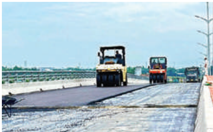
Tuyến đường kết nối từ trung tâm thị xã An Nhơn đến đường phía Tây đầm Thị Nại đang được nhà thầu gấp rút hoàn thiện
