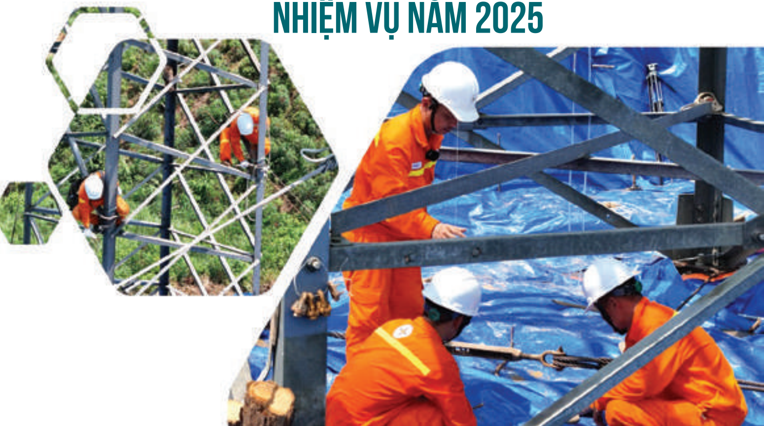
PTC1 khắc phục sự cố tại vị trí cột 79 thuộc ĐZ 220kV Tuyên Quang - Yên Bái sau cơn bão số 3 (YAGI)
