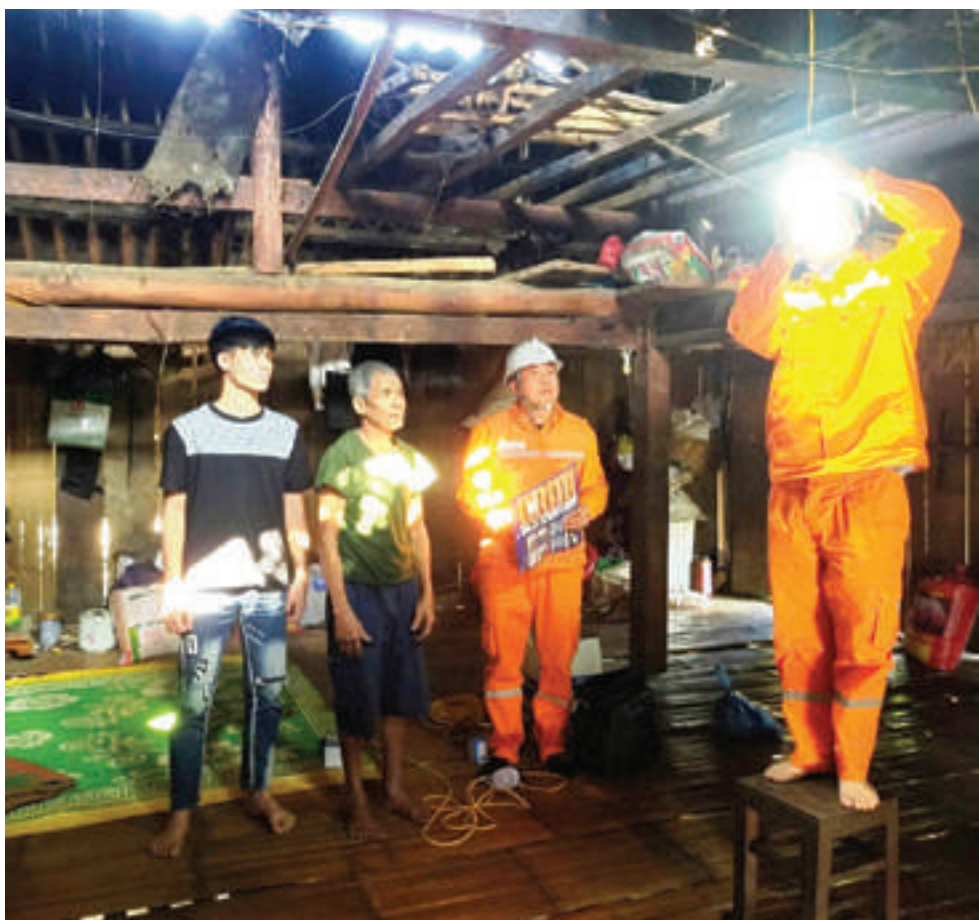
Công nhân Điện lực Pắc Nặm thay thế thiết bị điện miễn phí cho ông Đặng Văn Lòng (thôn Khuổi Bẻ, xã Bộc Bố)
