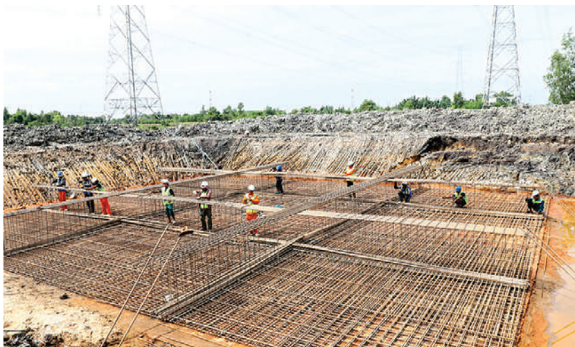
Nhà thầu thi công đã huy động tối đa nhân lực để thi công vị trí móng khi có mặt bằng
