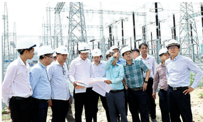
Đoàn công tác EVNNPT kiểm tra thi công vị trí đầu nối vào Sân phân phối Nhà máy điện Nhơn Trạch 3
