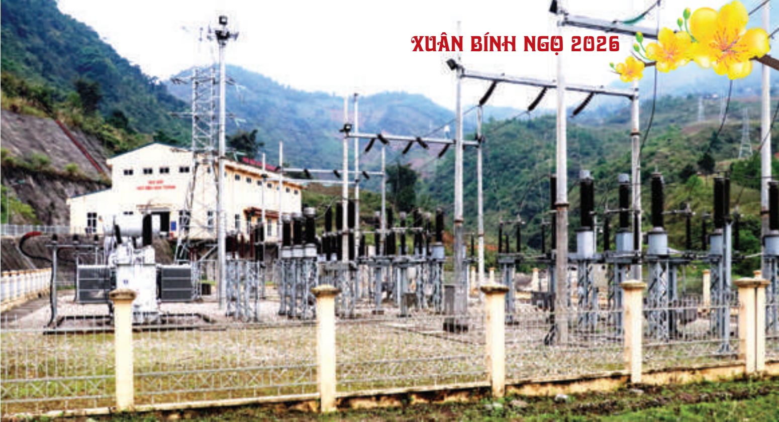
Quang cảnh Nhà máy Thủy điện Nậm Toóng
