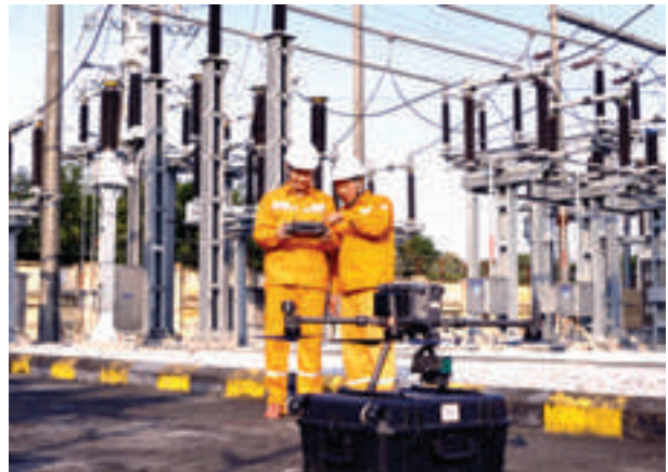
EVNNPC ứng dụng công nghệ UAV kiểm tra lưới điện ngoài hiện trường
