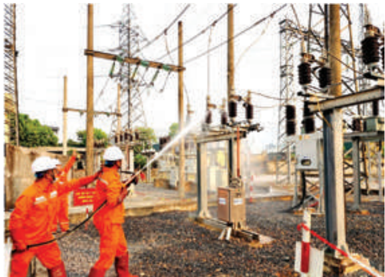
Công nhân CTĐL Sơn La vệ sinh công nghiệp bằng nước áp lực cao
