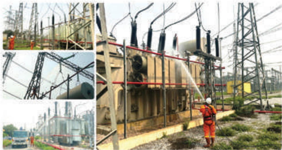
Vệ sinh hotline tại trạm biến áp 220kV Hà Đông trước cao điểm mùa nắng nóng
