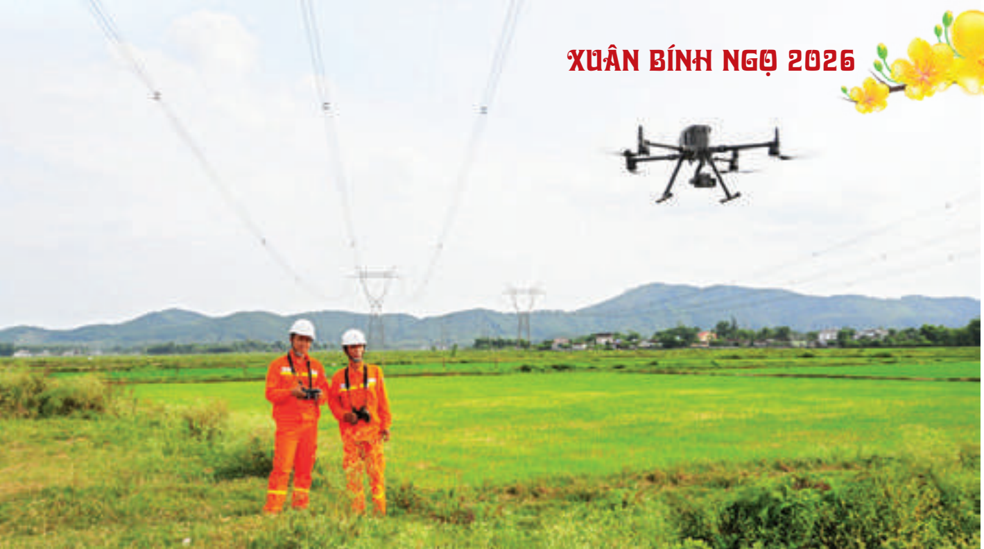
PTC1 ứng dụng UAV kiểm tra khiếm khuyết đường dây cao áp
